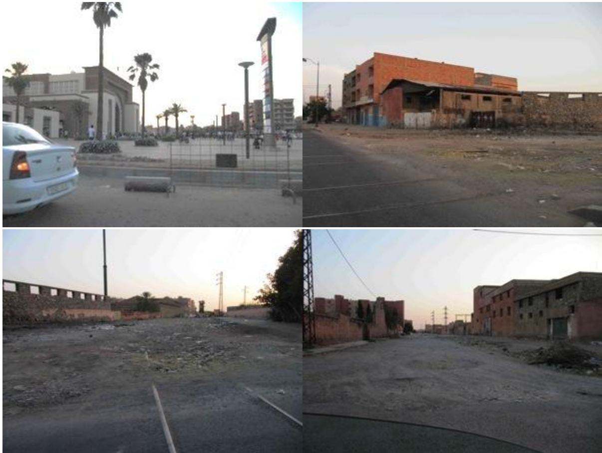
Figure 14 : Quartiers industriels en friche aux abords immédiats de la gare ONCF (en haut à gauche) : une opportunité foncière pour concevoir un quartier métropolitain de gare (source : PAB, 2013)
